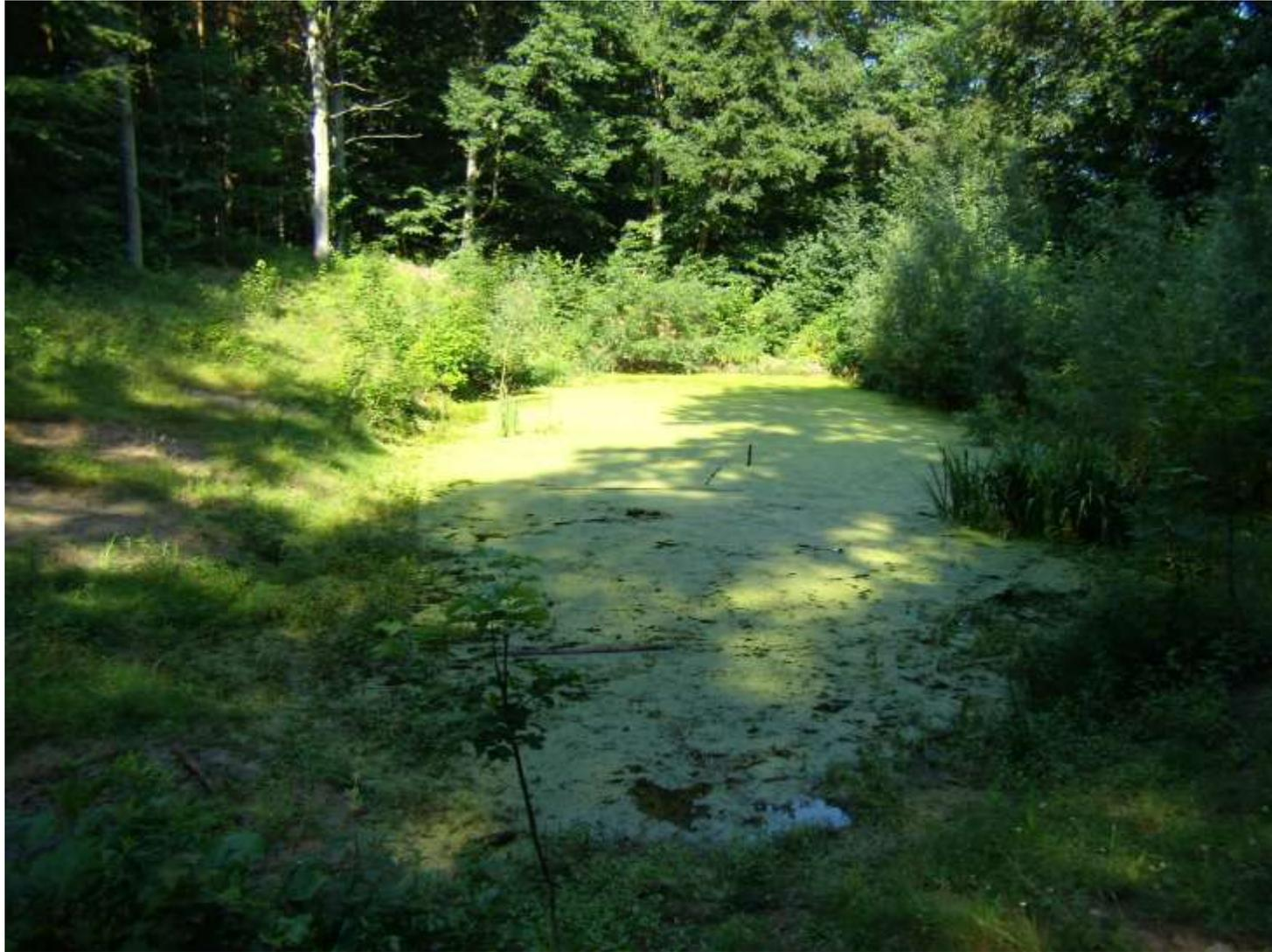
**190 m<sup>2</sup>, Retentions-/Versickerungsbecken, Zulauf Niederschlagswasser, kein Ablauf**
