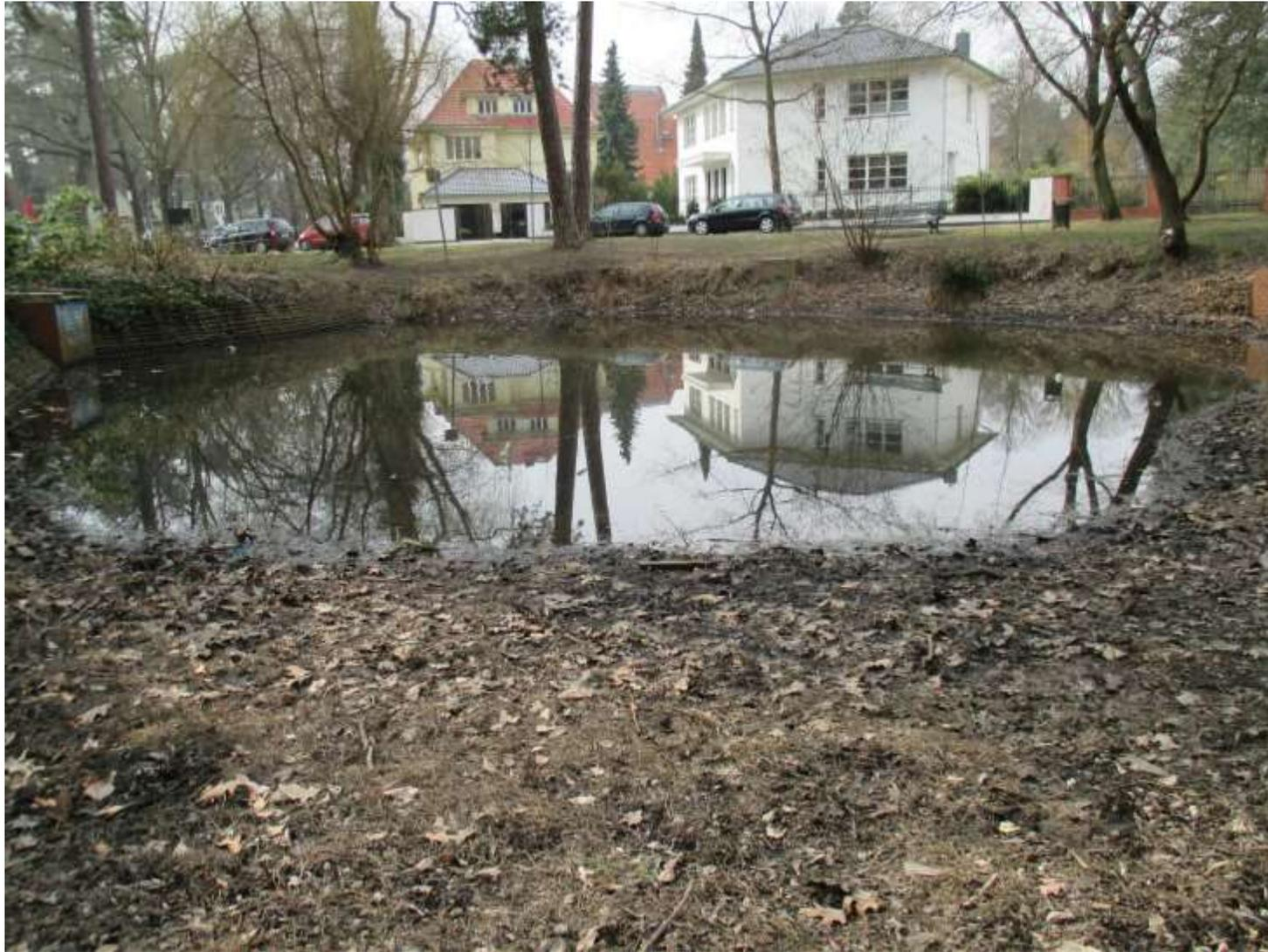
460 m<sup>2</sup>, Retentions-/Versickerungsbecken, Zulauf Niederschlagswasser, kein Ablauf
