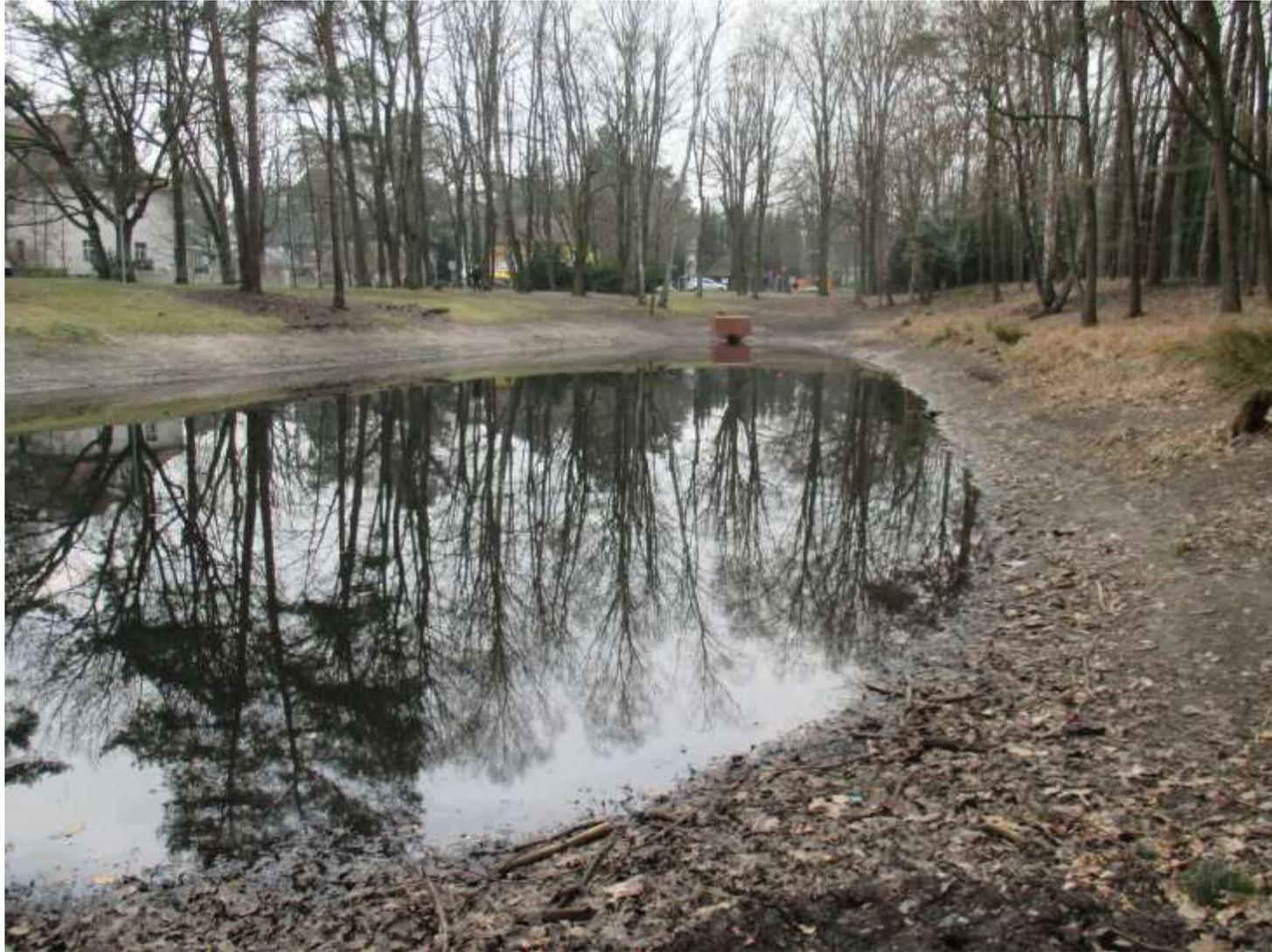
**1500 m<sup>2</sup>, Retentions-/Versickerungsbecken, Zulauf Niederschlagswasser, kein Ablauf**
