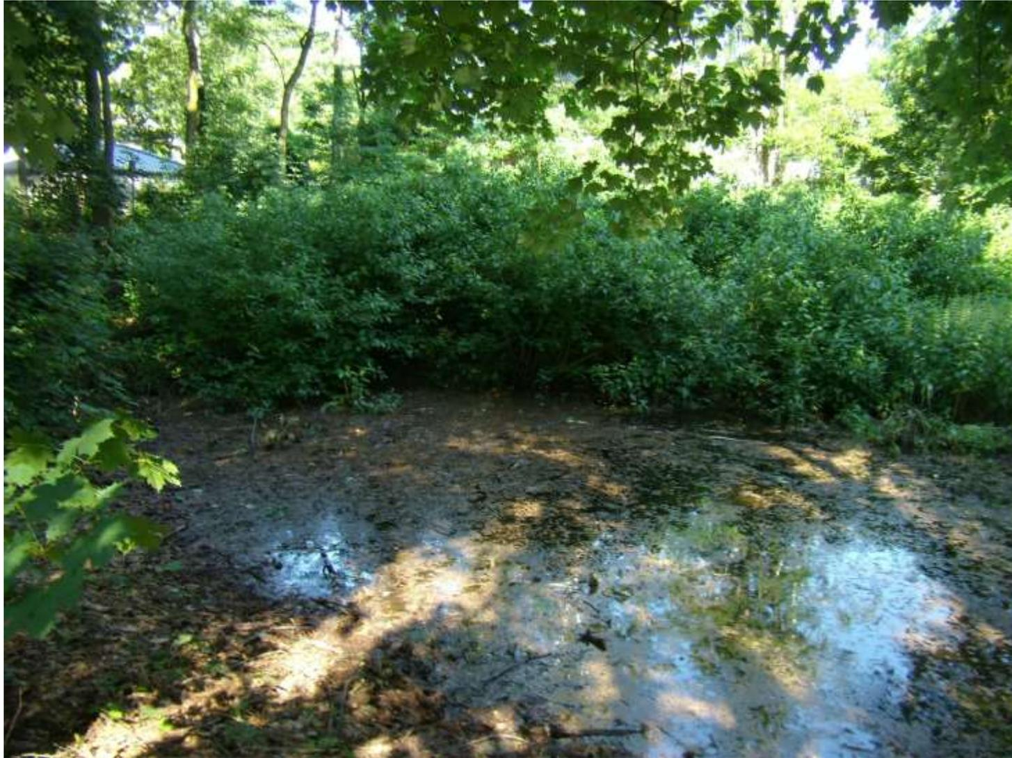
**1260 m<sup>2</sup>, Retentions-/Versickerungsbecken, Zulauf Niederschlagswasser, kein Ablauf**
