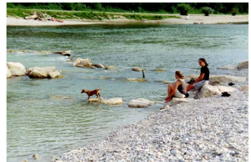
Naturnahe Rampe (Riegelbauweise)
