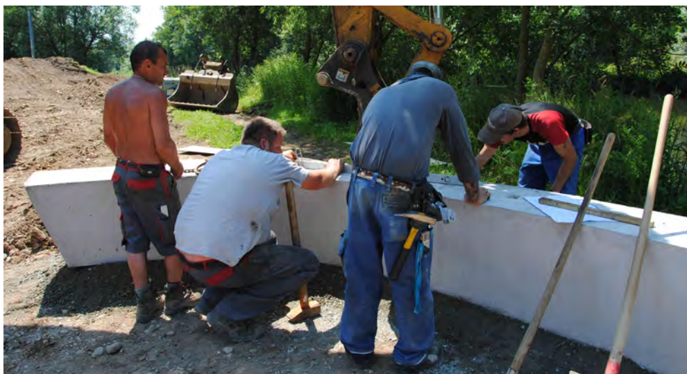
Abb. 13: Präzisionsarbeit beim Zusammenfügen der Elemente. Photo: Isolde Britz.
