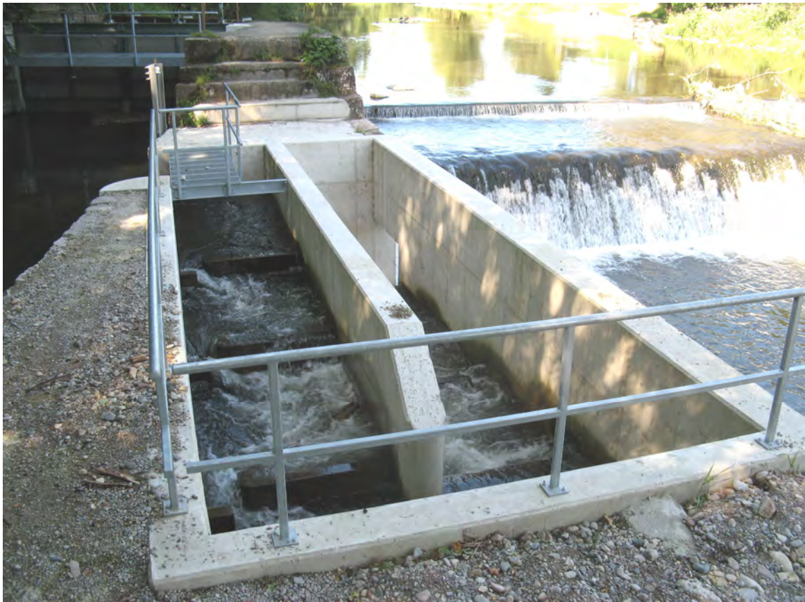
Abb. 9: Technischer Fischpass. Links oben ist die Ausleitung des Weilmühlekanals sichtbar. Photo: Daniel Rüetschi.
