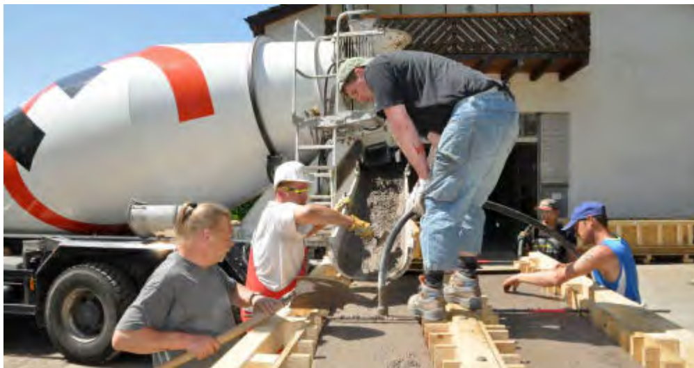
Abb. 12: Giessen der Betonelemente. Photo: Wolfgang Göckel.
