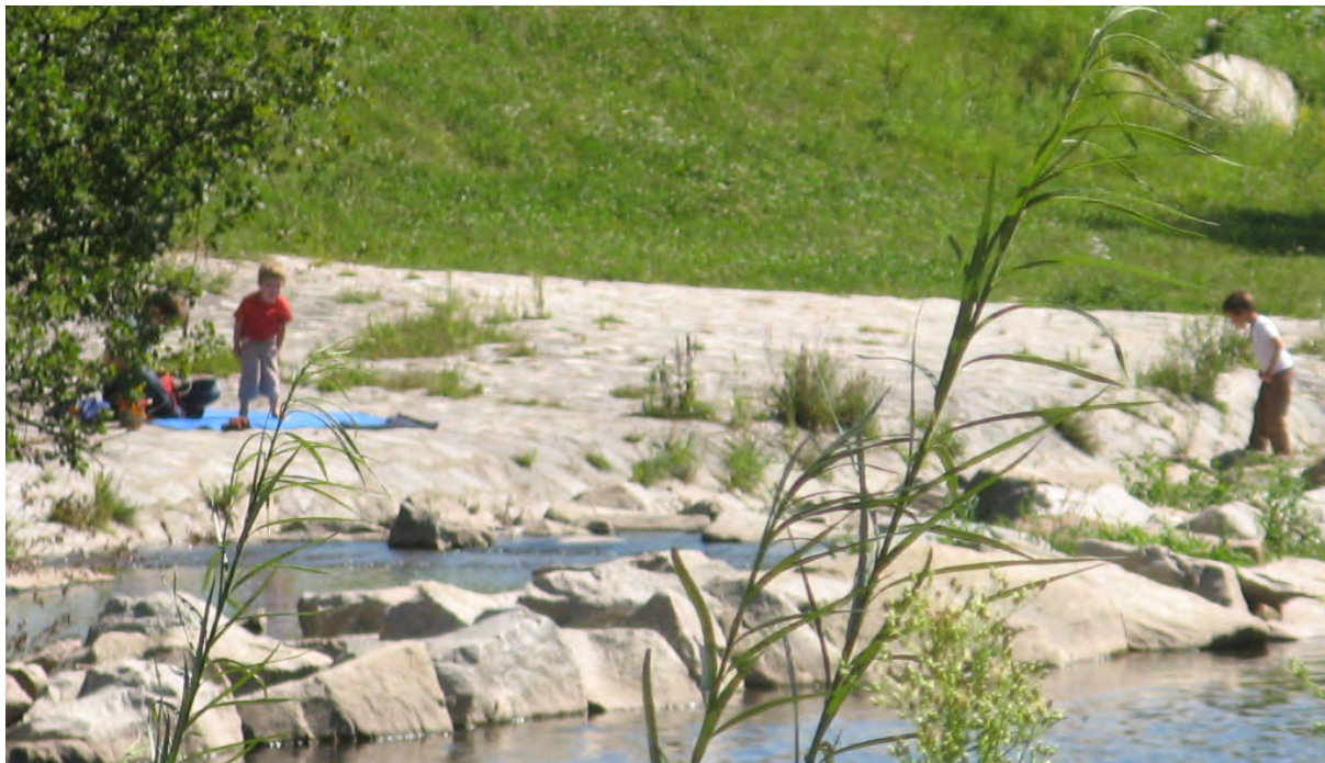
Abb. 10: Der Leitriegel zur Verstärkung der Lückströmung des Umgehungsgewässers bei Niedrigwasser oberhalb der Rauen Rampe wird als Spielplatz genutzt. Photo: Daniel Rüetschi.
