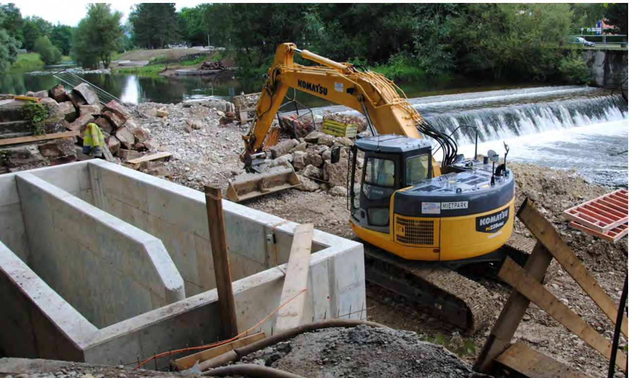
Abb. 8: Bau des Technischen Fischpasses. Photo: Isolde Britz.
